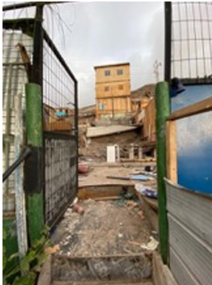
Figura 2 Terrenos y viviendas del Villa Esperanza en proceso de desarme.
